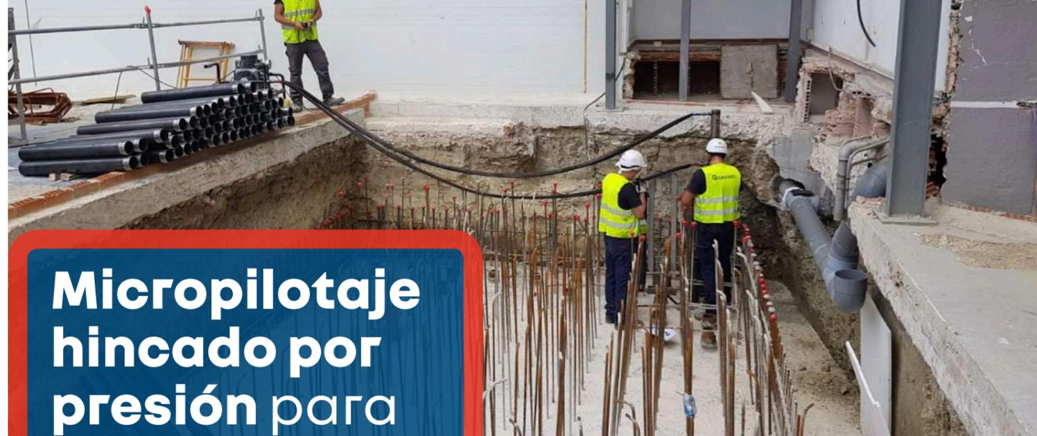
**Micropilotaje hincado por presión para rehabilitación de estructuras**
