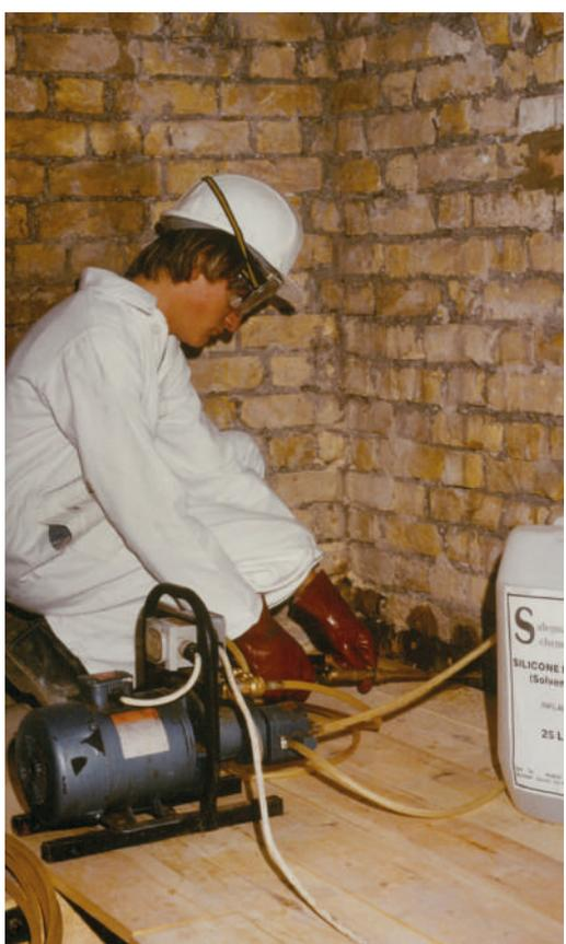
convertir una capa de mortero existente en una barrera impermeable utilizando cremas o geles antihumedad de alta resistencia.
